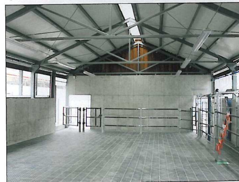
Před dojením se plemence shromažďují ve vyspádované čekárně
